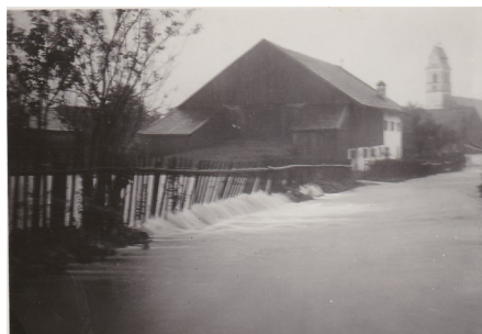
Ebnerhof beim Hochwasser 1952
